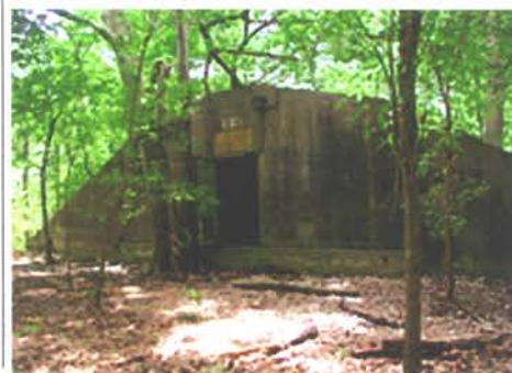
World War II Bunker - Belle Chasse
